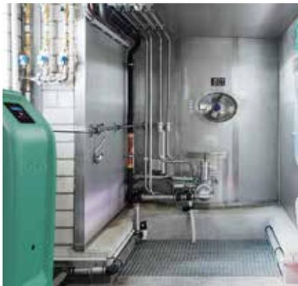
**Bei Neubau und Nachrüstung in der Konfiguration flexibel:** Ein verlängerter Auslauf und eine separat installierte ICool-Tanksteuerung ermöglichen das Positionieren des Tanks im gewissen räumlichen Abstand zum Gebäude.
